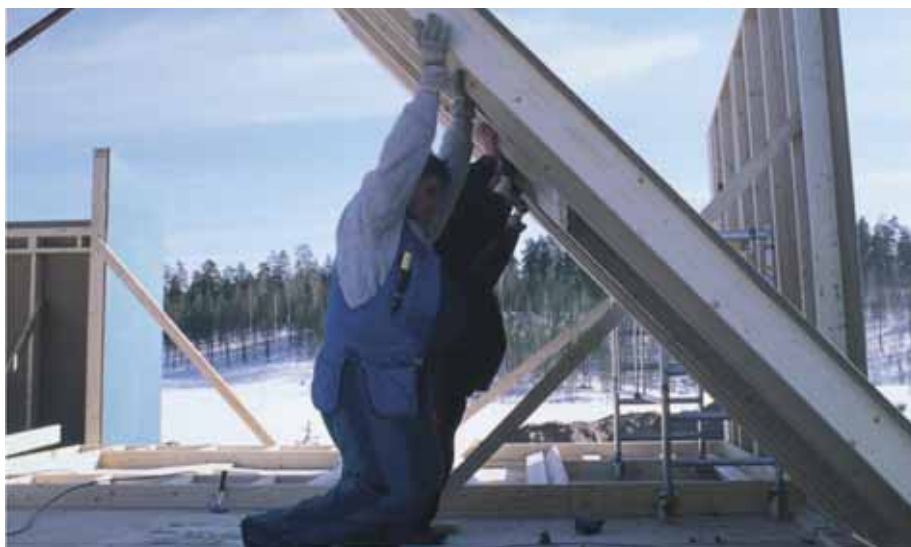
3, 4. Budowa przy wykorzystaniu systemu otwartej konstrukcji drewnianej. – Yrjö Skonto, Mikko Auernitty
